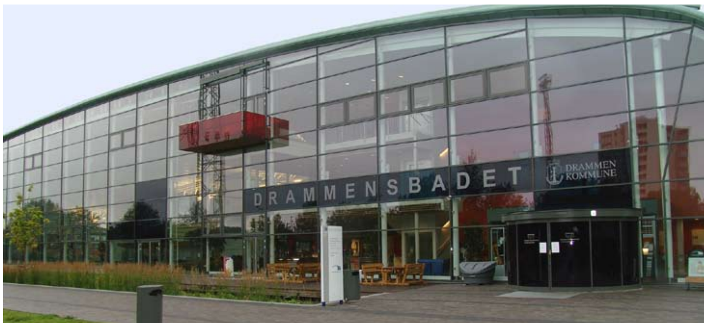
Drammensbadet er en av brukerne som har installert Eltek Fire & Safety brannalarm, talevarsling med PA-system og underholdningslyd.
