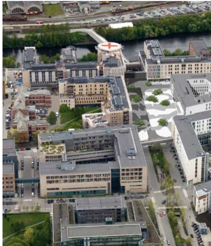
St. Olavs Hospital er en av brukerne som kan tilby sine "gjester" en høy grad av sikkerhet med talevarsling av brannmeldinger og andre uforut- sette hendelser. Systemet har mer enn 6000 høyttalere. Fotomontasje: Helsebygg Midt-Norge
